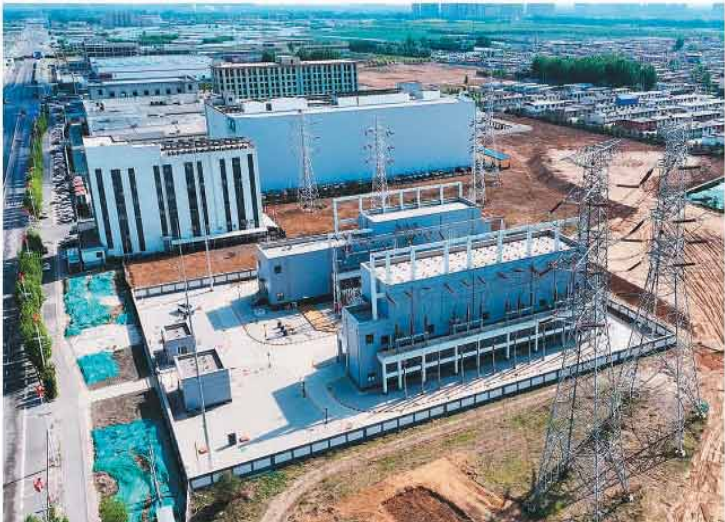
图为君瑞220千伏变电站全景。
