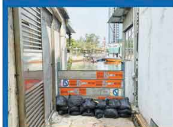
渠務署在鯉魚門安裝可拆式擋水板。
