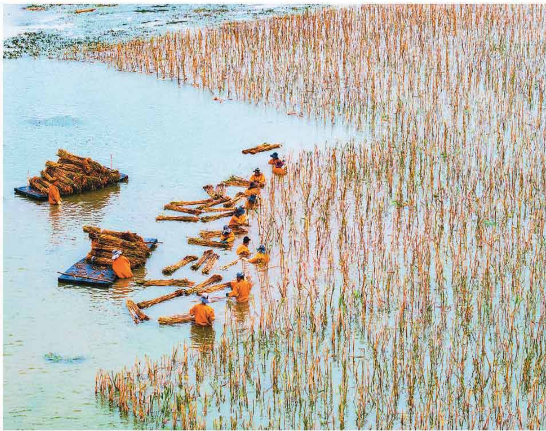
近年来,江苏省宿迁市泗洪县持续推进洪泽湖湿地生态修复,栽植原生植被,有效净化水质、涵养水土,筑牢湿地生态屏障。图为7月20日,泗洪县半城镇穆墩岛村洪泽湖巡护还湖区域,工人在开展芦苇插栽作业。
