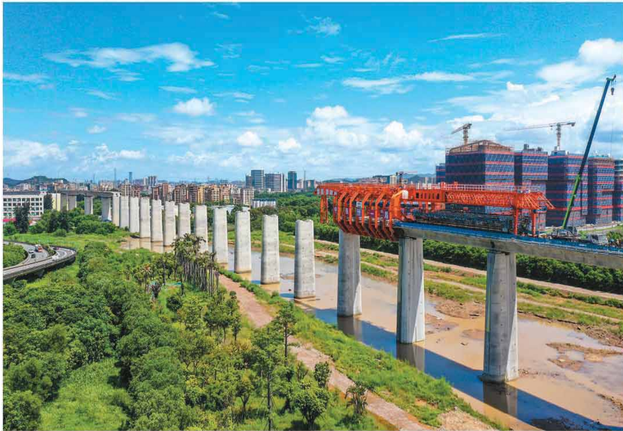
连日来，在位于广东东莞的深江铁路跨沿江高速特大桥建设现场，施工人员有序进行桥梁施工，大桥建设稳步推进。深江铁路是国家“八纵八横”高铁网沿海通道的重要组成部分，建成通车后，深圳与江门可实现1小时内通达，并将与广深港高铁连接，对进一步打造“轨道上的大湾区”具有重要意义。图为深江铁路跨沿江高速特大桥建设现场。
