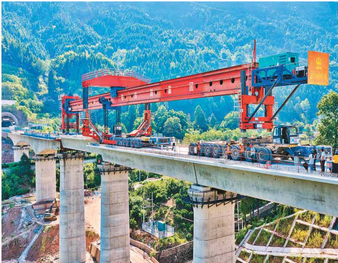
7月14日，随着最后一孔长32米、重约700吨的箱梁精准落位四川省达州市境内的西渝高铁坝坝村跨恩广高速公路大桥桥墩，西渝高铁全线箱梁架设任务顺利完成，为全线按期通车奠定坚实基础。西渝高铁是陕西西安至重庆的高速铁路，全长739公里，是中国“八纵八横”高铁网京昆通道和包（银）海通道的重要组成部分。图为架梁施工作业现场。
