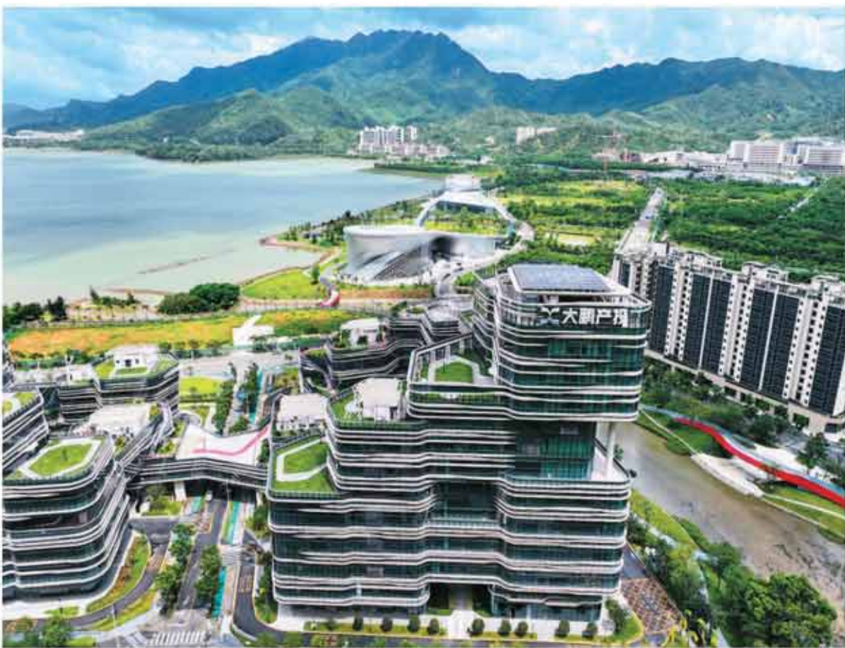
近日，由深圳大鹏新区产业投资集团投资建设的深蓝科技园圆满竣工并顺利通过验收。该项目位于广东省深圳市大鹏新区，以自然之道为设计理念，6栋建筑群从绿意中生长而出，将现代建筑美学与山海生态格局有机融合。图为深蓝科技园一隅。
