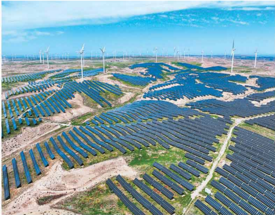
宁夏是国家“西电东送”重要送端和全国首个新能源综合示范区,近年来,当地在沙漠、戈壁、荒漠地区大力发展清洁能源产业,推动经济社会高质量发展。 图为俯瞰位于宁夏吴忠市红寺堡区的一处新能源基地,光伏板与风力发电机遥相呼应。 袁宏彦摄 (人民图片)
