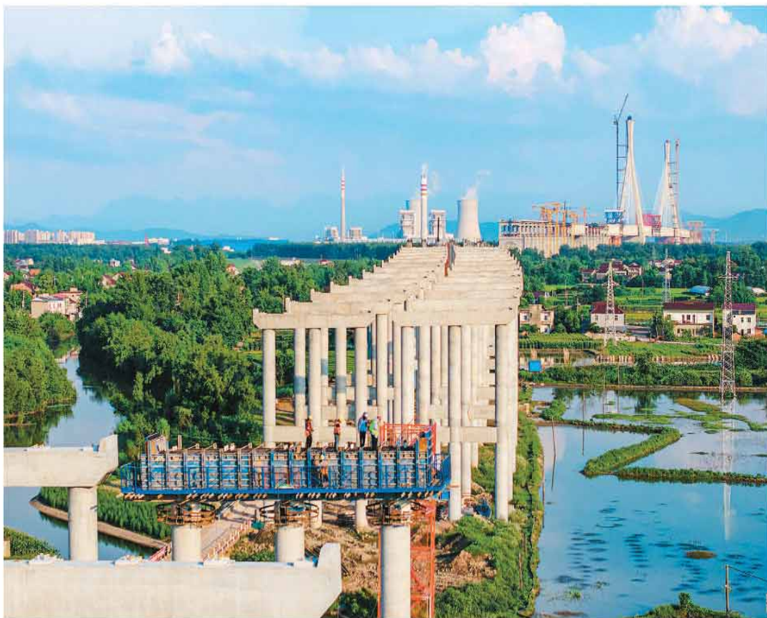
S40安徽宁国至枞阳高速公路铜陵段总长约19.7公里,贯穿铜陵市郊区、枞阳县等多个乡镇村落,建成后将进一步加密皖江地区高速通道,完善市域路网体系。图为宁枞高速铜陵段一标项目现场,工人正在进行桥梁墩柱施工。
