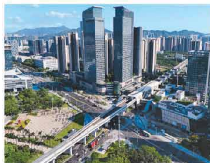
深圳地铁13号线二期（北延）近日正式开通运营，由中建四局承建的全线关键换乘枢纽凤凰城站同步投入使用。该站紧邻既有运营地铁线路，安全管控要求严苛，项目团队通过智能吊装、装配式绿色施工等多项技术创新，高效攻克施工难题。线路通车后将串联南山、宝安、光明三区，完善深圳北部轨道交通网络。
