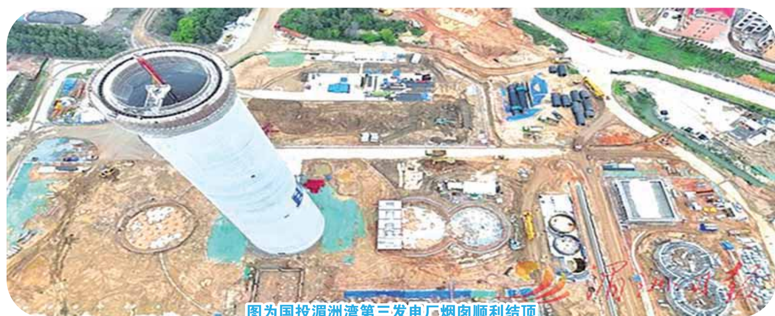
图为国投湄洲湾第三发电厂烟囱顺利结顶
