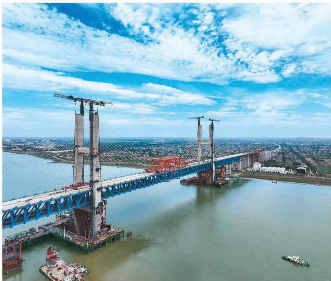
6月9日，连接上海崇明至江苏启东的崇启公铁长江大桥主桥成功合龙。崇启公铁长江大桥是中国“八纵八横”高速铁路沿江通道主干线——沪渝蓉沿江高铁的关键控制性工程，全长4.09公里，主跨400米，横跨长江入海口北支航道。大桥通车后，上海至启东铁路通行时间将从两个半小时缩短至半小时，对完善长江经济带综合立体交通走廊、服务长三角一体化高质量发展具有重要意义。图为大桥合龙现场。 新华社记者 季春鹏摄
