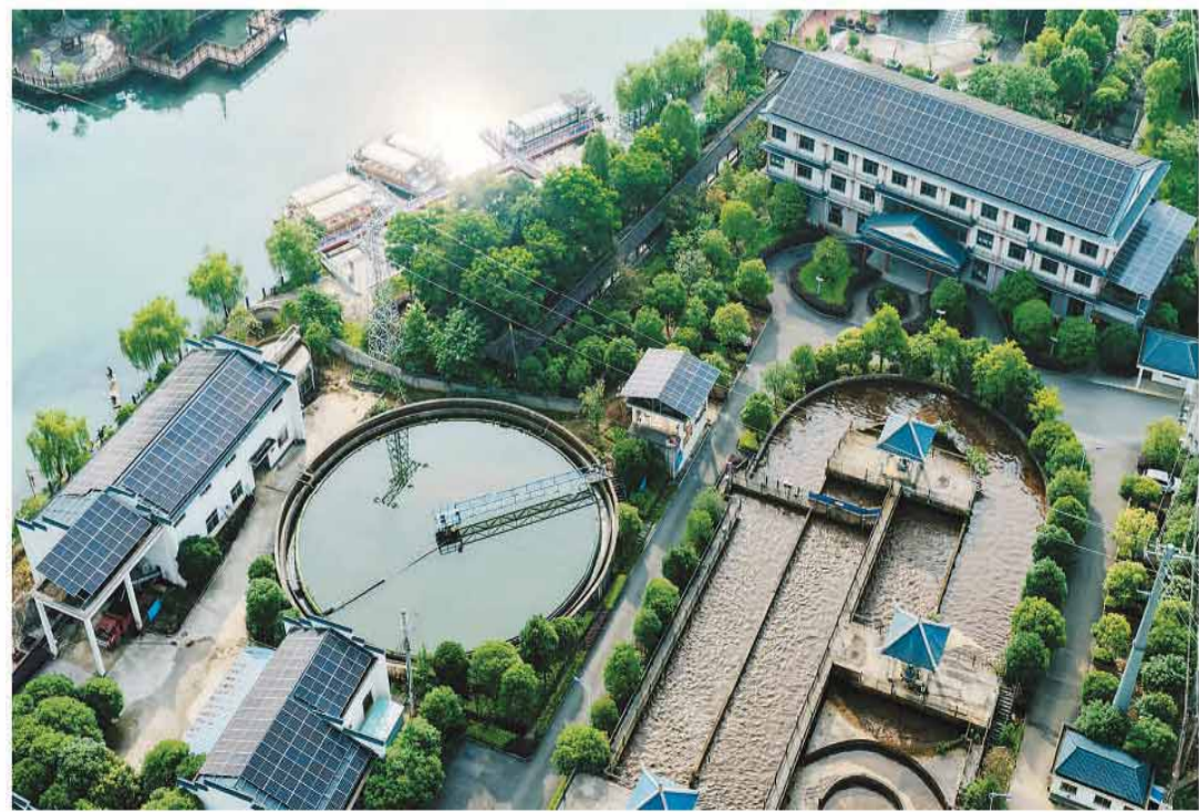
近年来，湖南省邵阳市城步苗族自治县鼓励单位与居民利用闲置屋顶建设分布式光伏发电项目，助推经济效益和生态效益“双赢”。图为城步苗族自治县污水处理厂，蓝色光伏发电板在屋顶上整齐有序排列。
