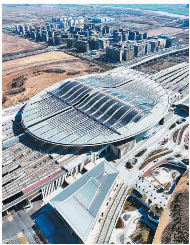
图为京雄城际铁路雄安站。站顶分布式光伏电站总装机容量6000千瓦,铺设1.77万块、4.2万平方米多晶硅光伏组件。
