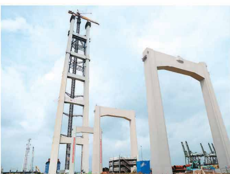
图为狮子洋大桥东主塔。
