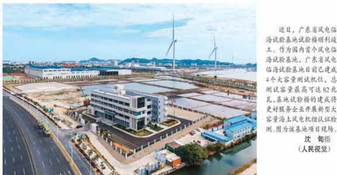
近日，广东省风电海试基地试验顺利竣工。作为国内首个风电海试基地，广东省风电海试基地目前已建成4个大容量测试机位，总测试容量最高可达82兆瓦。基地试验楼的建成将更好服务企业开展新型大容量海上风电机组认证检测。图为该基地项目现场。 沈甸摄（人民视觉）
