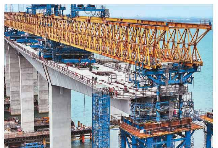
2月27日，在江苏省张家港市，张靖皋长江大桥南航道桥施工现场热火朝天，中交二航局的建设者们有序进行施工作业，高标准、高质量推进大桥项目建设。图为项目施工现场。施柏荣摄（人民视觉）
