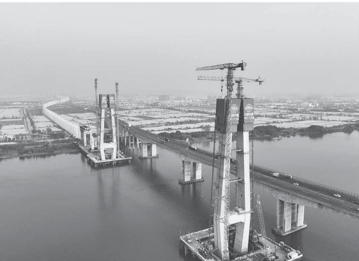
近日，由中铁二十五局承建的深江铁路重难点工程——广中江特大桥跨虎跳门水道斜拉桥17号、18号双主塔施工高度顺利突破百米大关。作为粤港澳大湾区轨道交通网络的重要组成部分，深江铁路正线全长116公里，建成后将实现深圳前海自贸片区与广州南沙自贸片区半小时高铁互联互通。图为广中江特大桥跨虎跳门水道斜拉桥施工现场。
