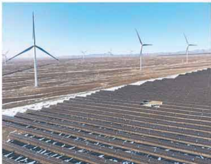
图为新疆生产建设兵团第六师北塔山牧场风电场。近年来，当地深挖资源优势，利用荒漠山地大力发展风电产业，有力推动新能源产业高质量发展。
