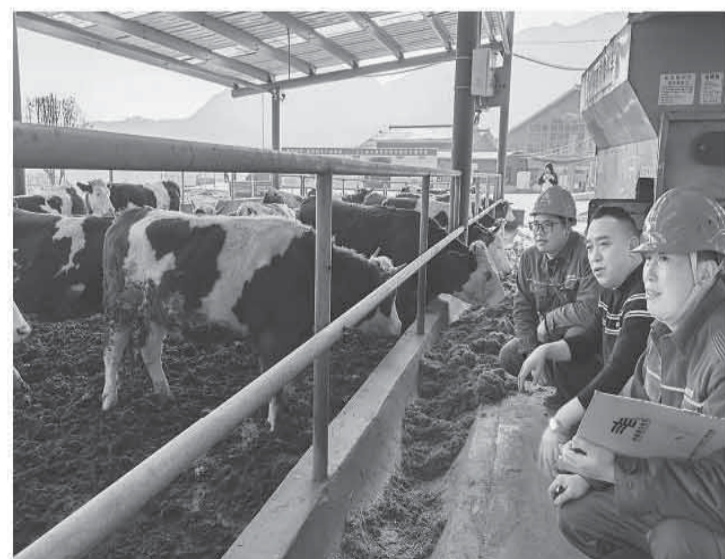
素有“中国牛肉粉之乡”之称的贵州省黔东南苗族侗族自治州兴仁市,近来以粤港澳大湾区绿色农产品供应基地为平台,实现肉牛繁育、屠宰、加工、销售全产业链发展。图为南方电网兴仁供电局工作人员在兴仁市大湾区活牛保供交易中心进行配电设备安全检查。
