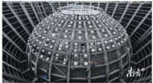
江門中微子實驗探測器，中心探測器外工人正在高空安裝光電倍增管模塊，那是探測器的眼睛。劉悅湘攝
