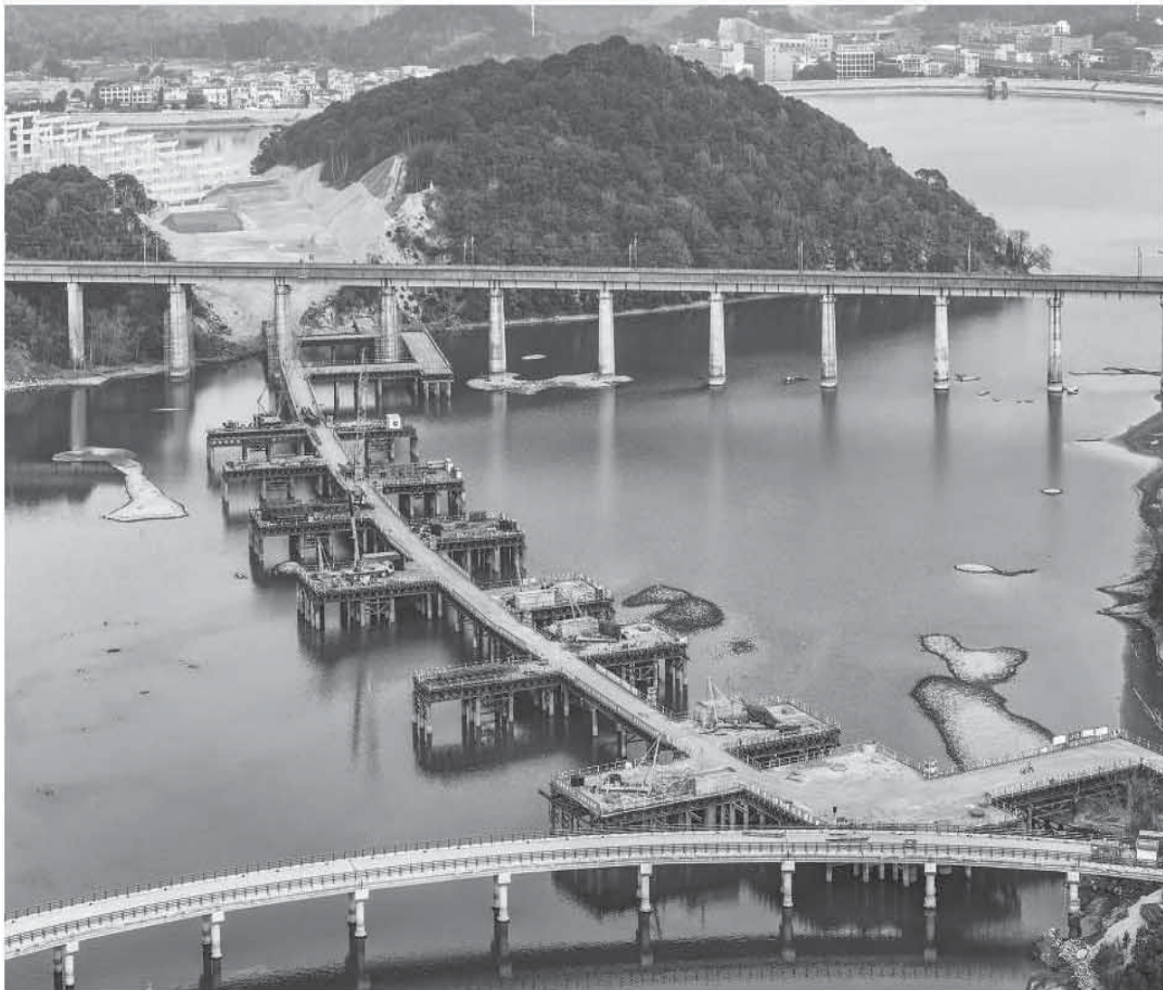
杨梅岭水库大桥位于浙江省宁波市宁海县境内，是G15沈海（辽宁沈阳至海南海口）离连宁波西坞至麻谷岭段改扩建工程的重要一环，也是国家沿海综合运输大通道的组成部分，建成后将助力区域经济社会发展，进一步发挥高速公路网规模效益。图为杨梅岭水库大桥施工现场。
