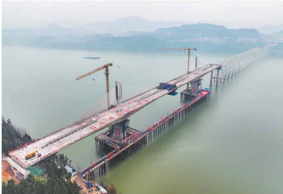
1月19日,连接四川省阆中市与营山县的阆营高速控制性工程嘉陵江特大桥顺利合龙,为全桥贯通打下基础。该桥全长1379米,宽32.5米。网管高速全长103公里,是四川省高速公路网重要组成部分,建成通车后,将进一步串联起川东北区域路网。图为嘉陵江特大桥。
