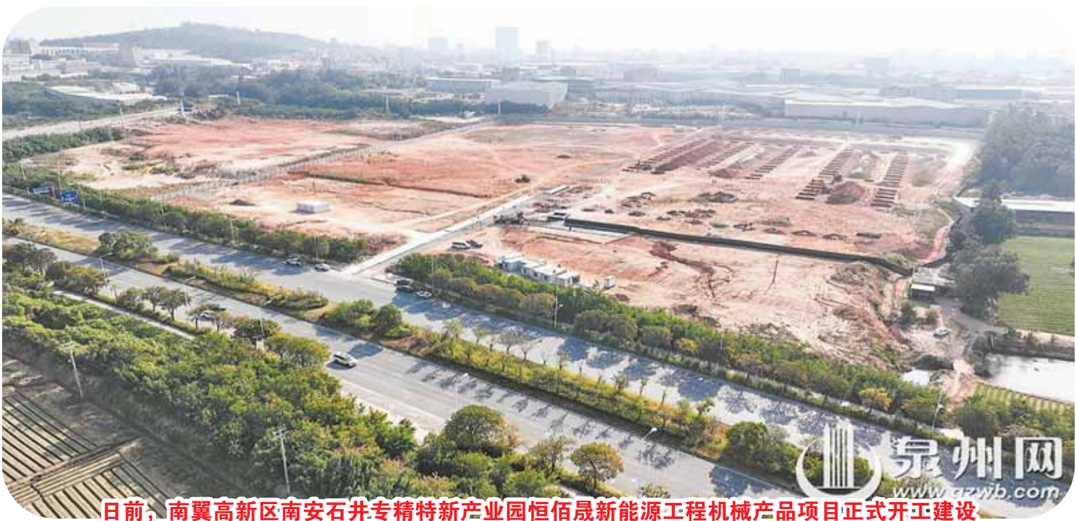
日前，南翼高新区南安石井专精特新产业园恒佰晟新能源工程机械产品项目正式开工建设。
