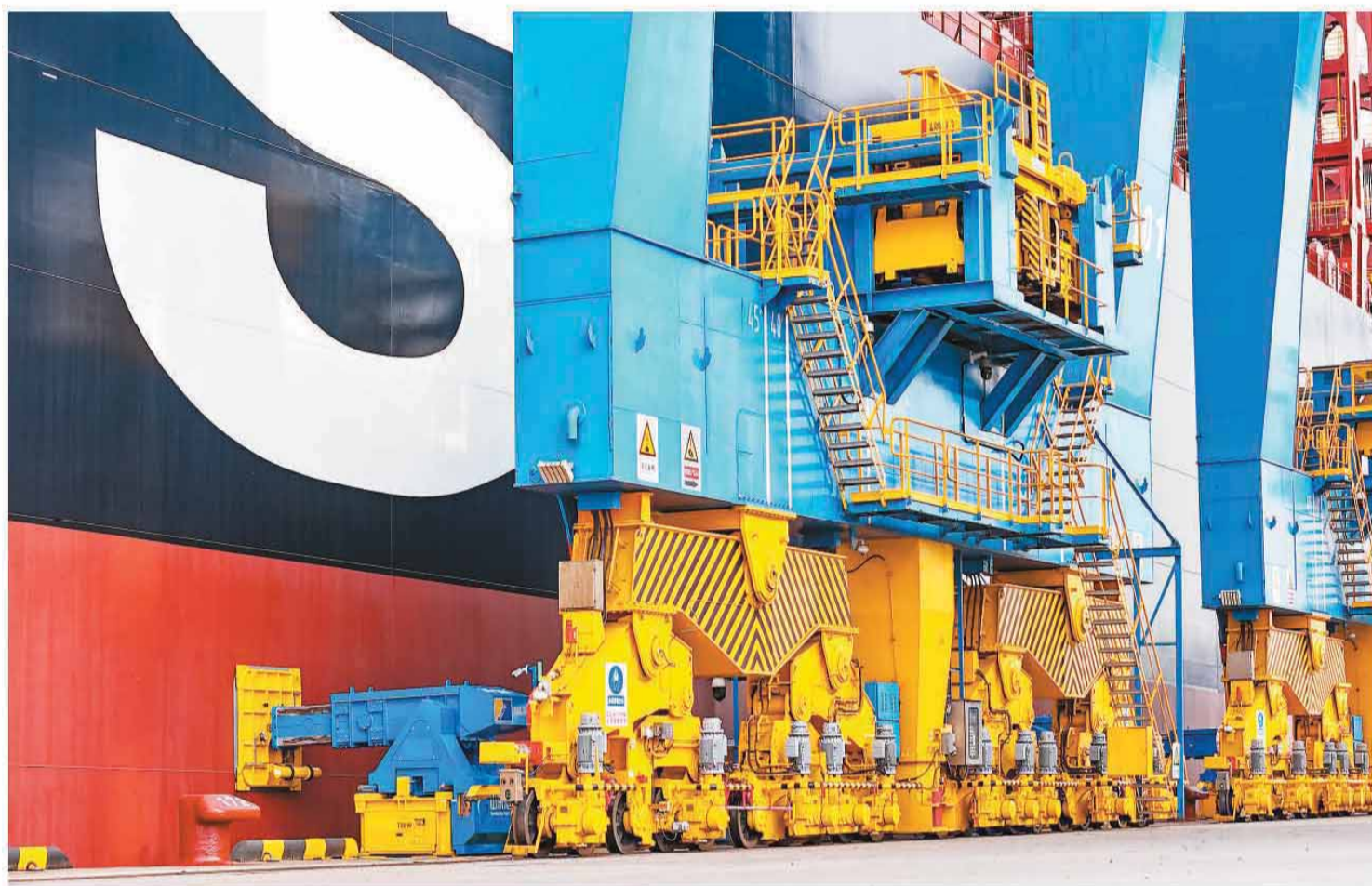
近日，中国首套真空式自动系泊系统在山东省青岛港全自动化集装箱码头正式投用。该系统通过部署在泊位上的13套系泊单元，可自动完成对200米以上大型集装箱船舶的精准吸附与固定，将单船系泊作业时间从传统的20—30分钟大幅缩短至30秒以内，实现了该环节从人工操作到自动智能作业的效率提升。图为正在作业中的自动系泊系统。张进刚摄（人民视觉）
