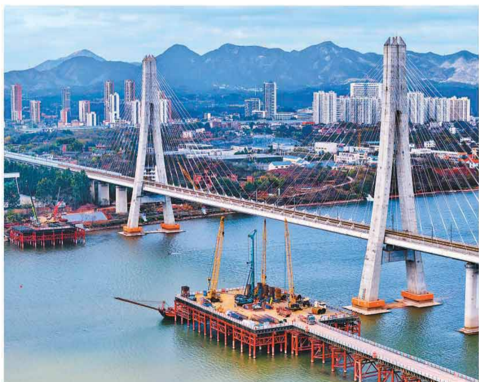
建设现场。长赣高铁是中国“八纵八横”高速铁路网主通道之一“渝昆通道”的重要组成部分，建成通车后，将结束江西莲花、永新、井冈山、遂川等地不通高铁的历史。因为一月二日，长赣高铁赣江特大桥。朱海鹏摄（人民视觉）
