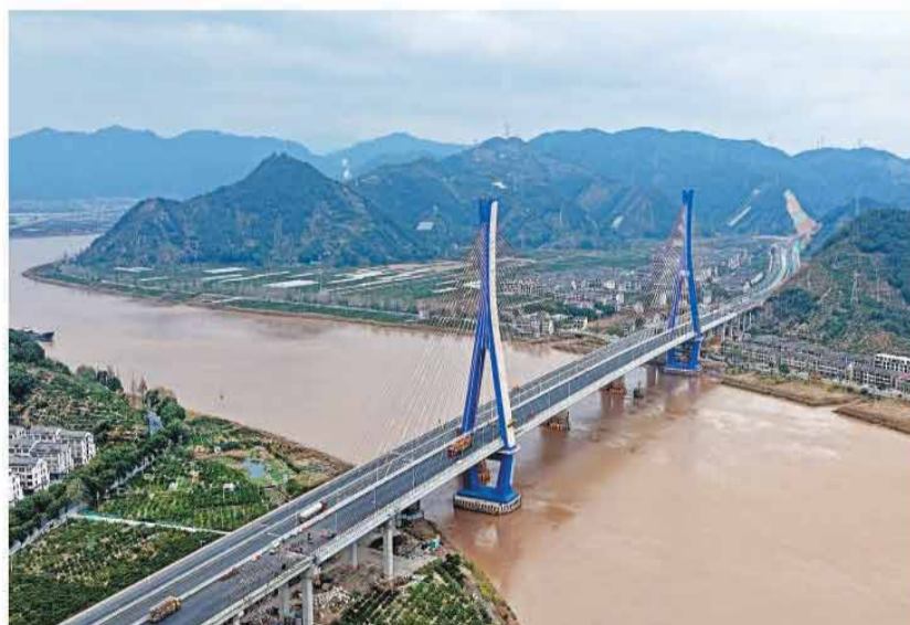
正在建设中的灵江特大桥是浙江省甬台温高速公路改扩建台州北段项目关键控制性工程,全长1690米,由南北引桥和主桥组成,其中主桥全长700米,主跨380米。
