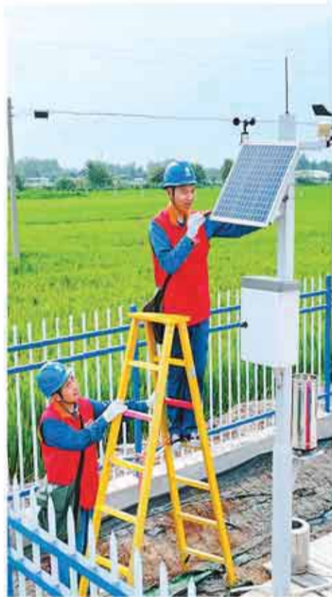
9月9日，在安徽省明光市石坝镇大李郑，工作人员正在对智能农业监测设备进行检修维护。 宋卫星摄(人民视觉)
