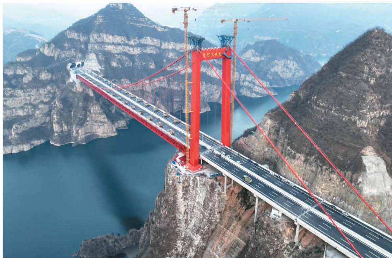
近日，世界首座独塔地锚式四转绕悬索桥——济(源)新(安)高速黄河三峡大桥顺利完成荷载试验。该桥地处河南省济源市与洛阳市新安县交界的王屋山—黛眉山世界地质公园，全长1688.5米、主跨555米、塔高109米。济新高速公路通车后，晋豫交通网络将进一步完善，促进地区经济发展。图为荷载试验现场。
