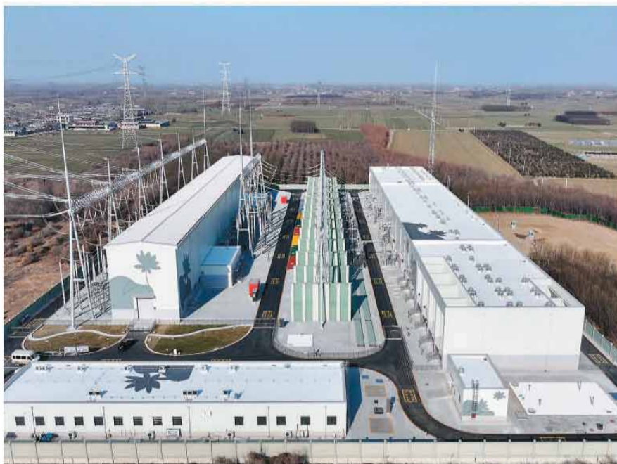
12月7日，河北雄安新区新能源输电通道关键枢纽变电站——雄安500千伏超高压变电站正式投运。该变电站是国家“十四五”规划重点项目，是将内蒙古和河北坝上地区风电、光伏发电等清洁能源引入雄安新区的关键站点。 新华社记者 杨世尧摄
