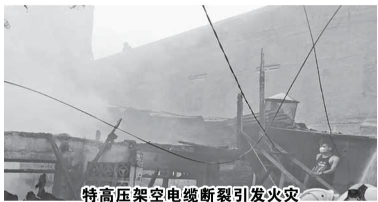
特高压架空电缆断裂引发火灾
