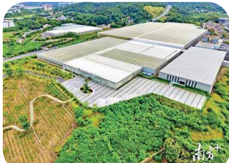
梅州市华发现代设施农业产业基地已全面投产。杨斐君摄
