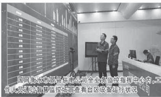
国网衡水市枣强县供电公司全业务监控指挥中心内，工作人员通过智慧监控大屏查看台区设备运行状况。
