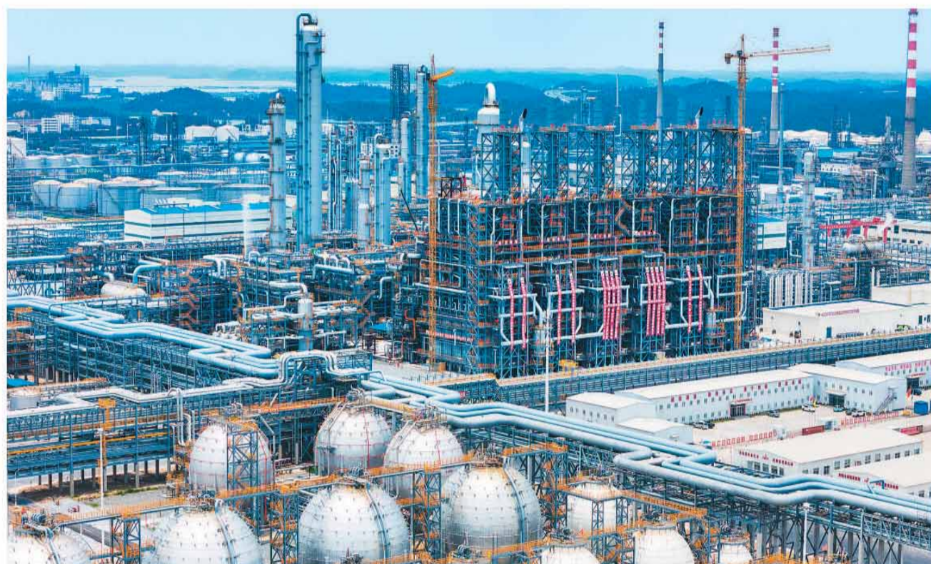
▲中国石油“十四五”重点工程——中国石油广西石化炼化一体化转型升级项目近日全面建成，进入联动试车阶段。图为该项目现场航拍图。
