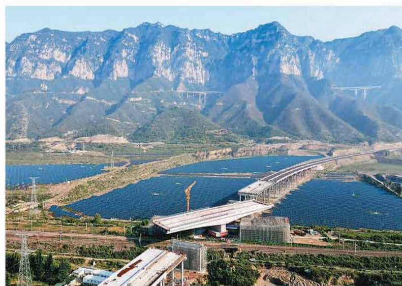
八月十一日，由中铁大桥局承建的河南省濮阳市沿太行山高速公路跨越焦作(州)铁路立交桥成功转体，转体主梁总长一百三十米，总重量达二万吨。图为跨越柳林铁路立交桥转体施工现场。新华社记者 朱梓煜 摄
