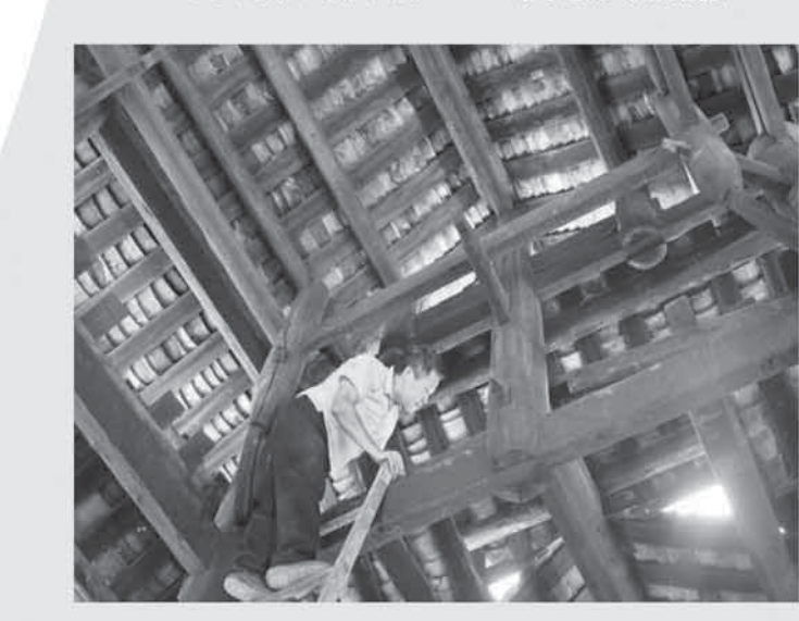
▲ 杨似玉爬上风雨桥内部的横梁检查桥梁的结构。黎寒池摄（人民视觉）
