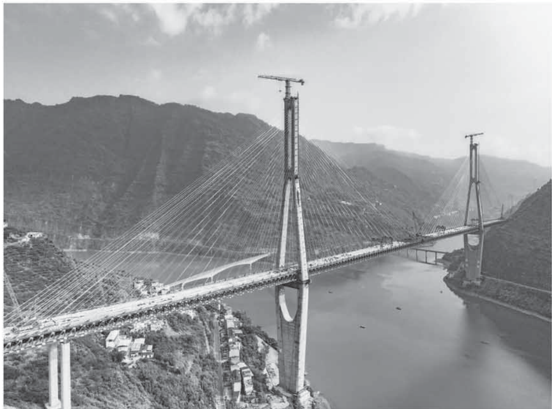
新市金沙江特大桥起点岸为四川省屏山县新市镇，止点岸为云南省绥江县南岸镇，总长1800余米，主跨680米，是连接四川与云南两省的重要枢纽。建成通车后，将有力助推当地经济社会发展。 图为屏山县新市金沙江特大桥建设现场。
